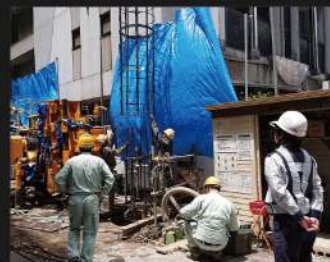
④ 土木工事
