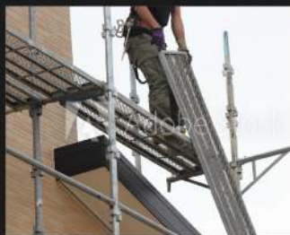
③ 足場組立工事
