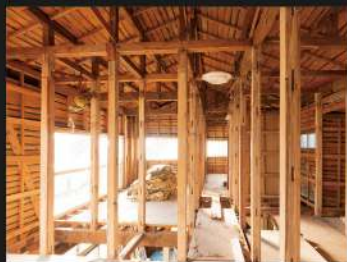
② 内装大工工事
